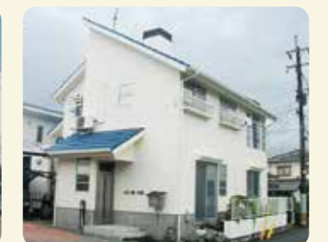
住宅屋根・外壁
