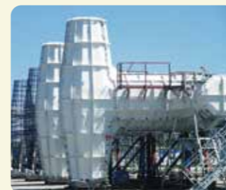
消波ブロック型枠
