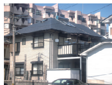
住宅屋根（コロニアル）
